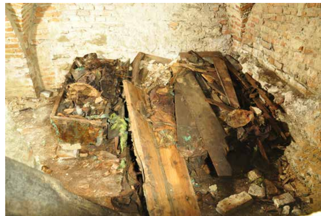
Ryc. 3.23. Krypta 3. Widok grobów 72-74 po rozebraniu zamurowanego wejścia od zachodu. Fot. S. Gołub
