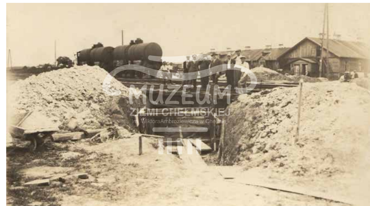
Prace przy układaniu przewodów kanalizacyjnych na terenach budowy gmachu Dyrekcji Kolejowej i Kolonii Mieszkalnej. Na rewersie odręczny napis: Przekop pod torem Kolejowym dla ułożenia przewodu Kanalizacyjnego. zbiory: Wojewódzka Biblioteka Publiczna im. Hieronima Łopacińskiego w Lublinie, sygn. 1873/II (5059/3).
