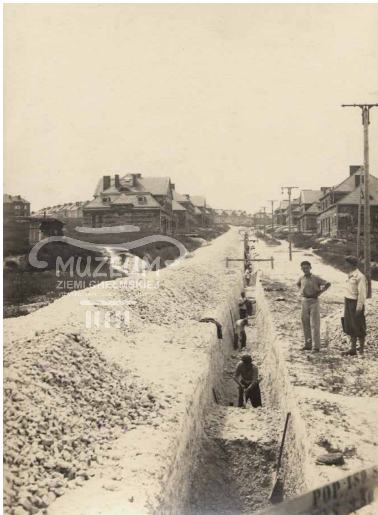
Ul. George'a Stephensona; 1932 r. Na rewersie odręczny napis: Wykop kanalizacyjny w grubym pokładzie kredowym. zbiory: Wojewódzka Biblioteka Publiczna im. Hieronima Łopacińskiego w Lublinie, sygn. 1873/II (5059/2).
