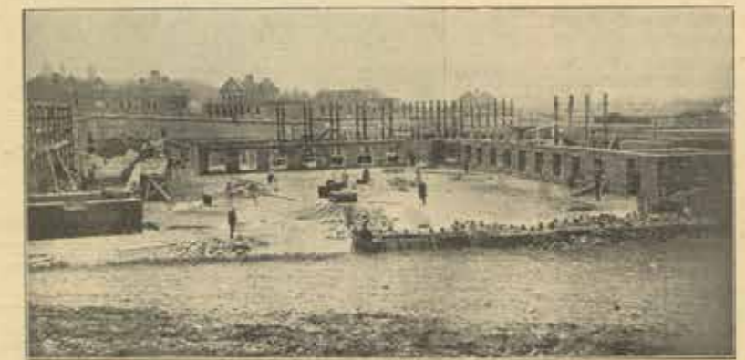
Stan robót w październiku 1928 roku przy budowie gmachu Dyrekcji Kolejowej w Chełmie.
