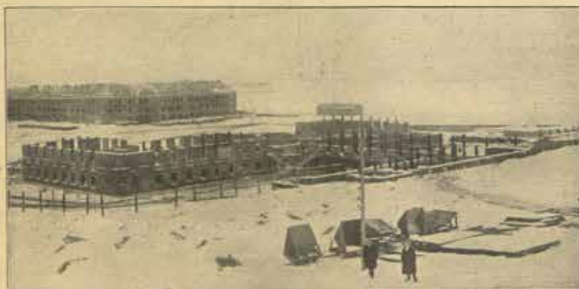
Stan robót w listopadzie 1928 r. przy budowie gmachu Dyrekcji Kolejowej w Chełmie. Roboty wykonała firma „TOR”
