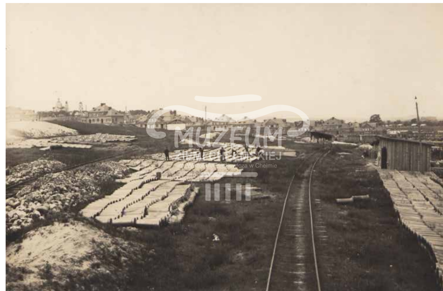
Na rewersie odręczny napis: Budowa kanalizacji w Chełmie Magazyny i pieczęć „M. Lempicki” S.A. w Sosnowcu; 1929–1933 zbiory: Wojewódzka Biblioteka Publiczna im. Hieronima Łopacińskiego w Lublinie, sygn. 1873/II (5059/7).
