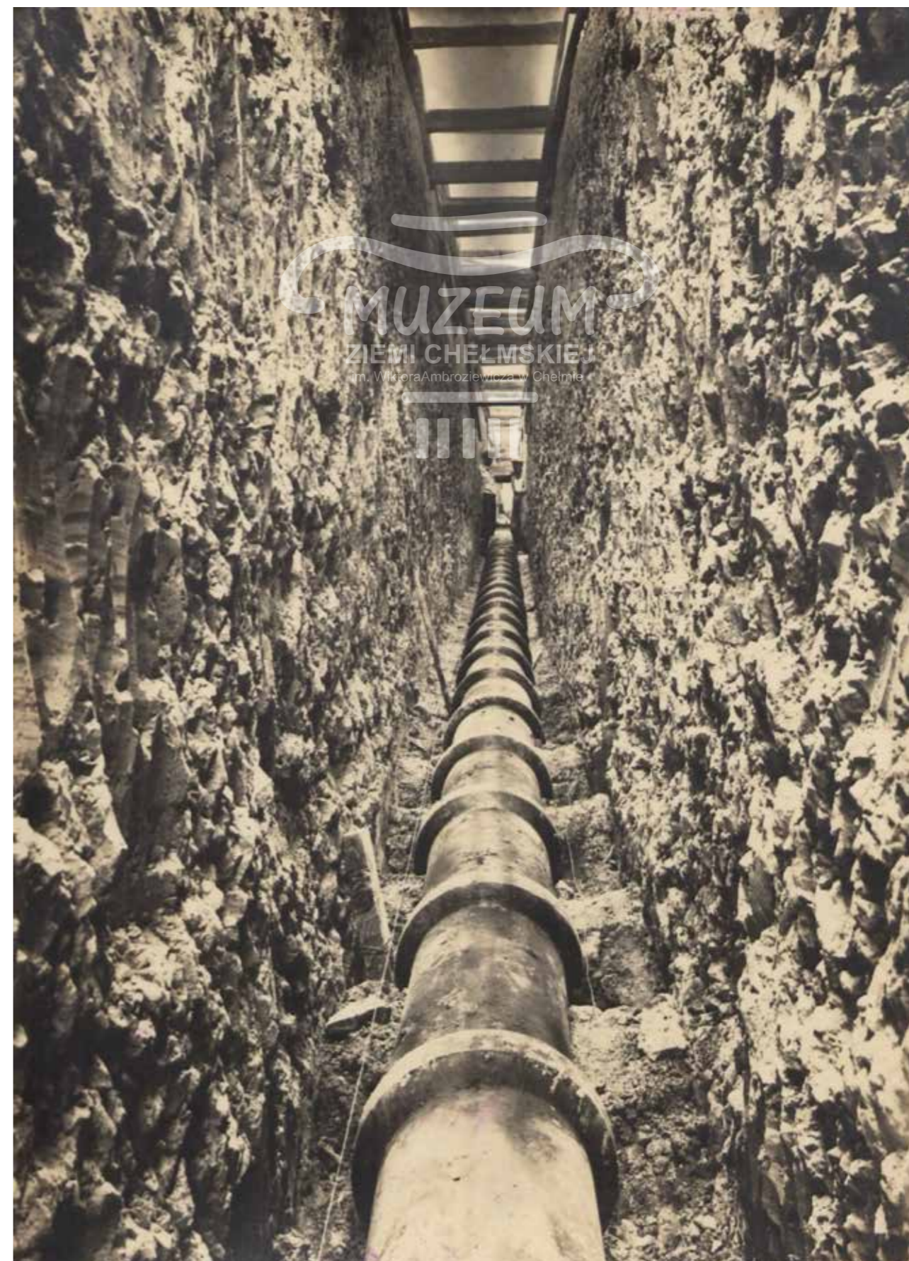
Układanie przewodów kanalizacyjnych na terenach budowy gmachu Dyrekcji Kolejowej i Kolonii Mieszkalnej zbiory: Wojewódzka Biblioteka Publiczna im. Hieronima Łopacińskiego w Lublinie, sygn. 1873/II (5059/4).
