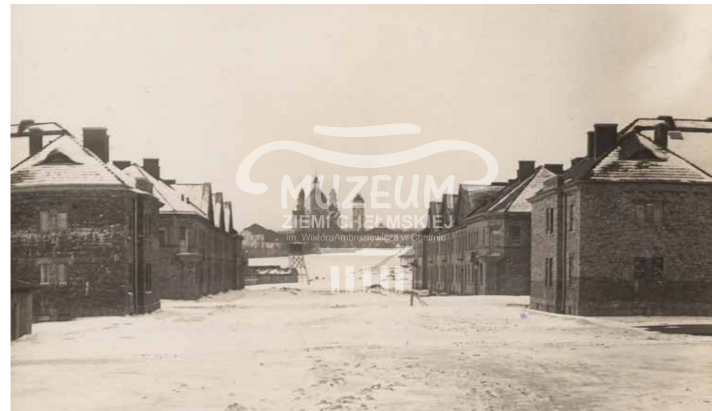
Ul. Katedralna. Na rewersie odręczny napis: Jedna z ulic na terenach budowy Kolonji mieszkalnej; 1929–1932. zbiory: Wojewódzka Biblioteka Publiczna im. Hieronima Łopacińskiego w Lublinie, sygn. 1874/II (5060/4).
